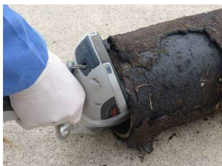
Foto 1. Bepaling van het kwikgehalte in een gasleiding met een handheld XRF.
